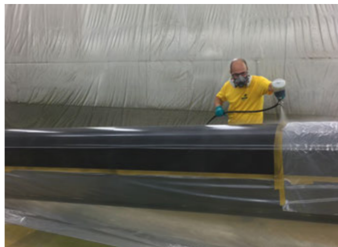
Overfladen, coated med Berucoat AF 339 til teleskopering, er berøringstør efter en time, kan udsættes for belastning efter 3 dage, og er gennemtør efter 7 dage
